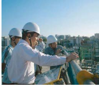
大橋ジャンクション建設現場
