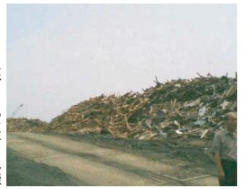
崩壊した家屋の瓦礫
